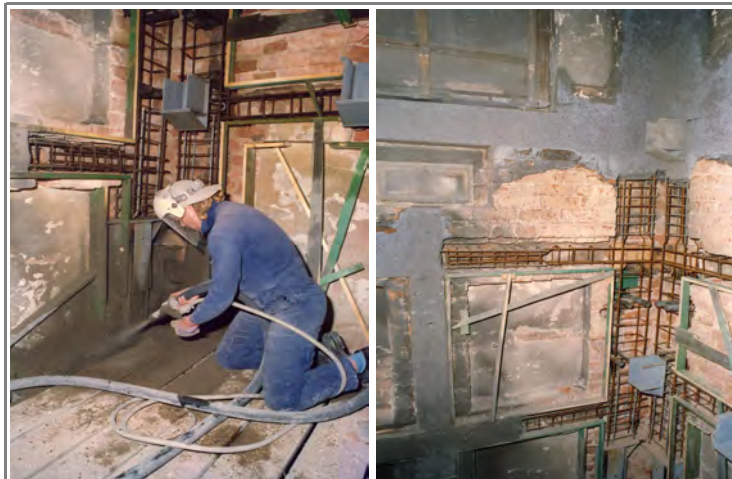
Sanierung der Tragkonstruktion mit Spritzbeton
