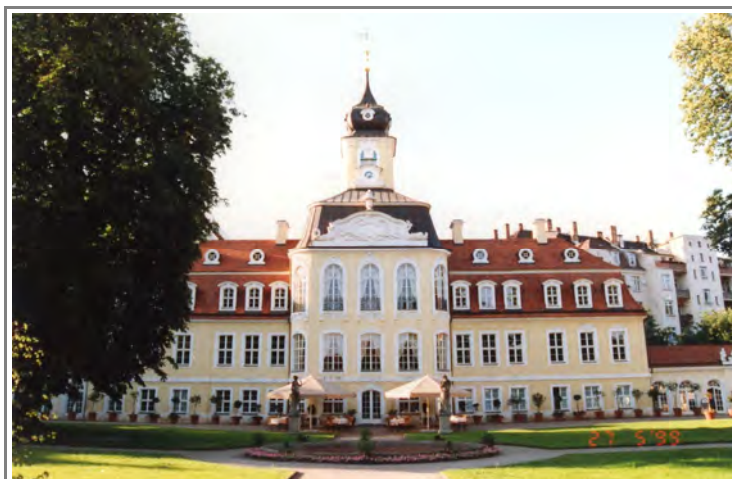
Gartenansicht nach Sanierung
