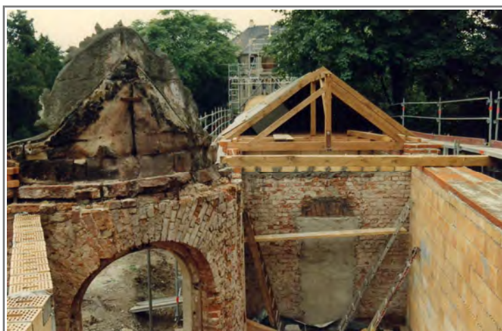
Sanierung der Wände/Dachkonstruktion Seitenflügel
