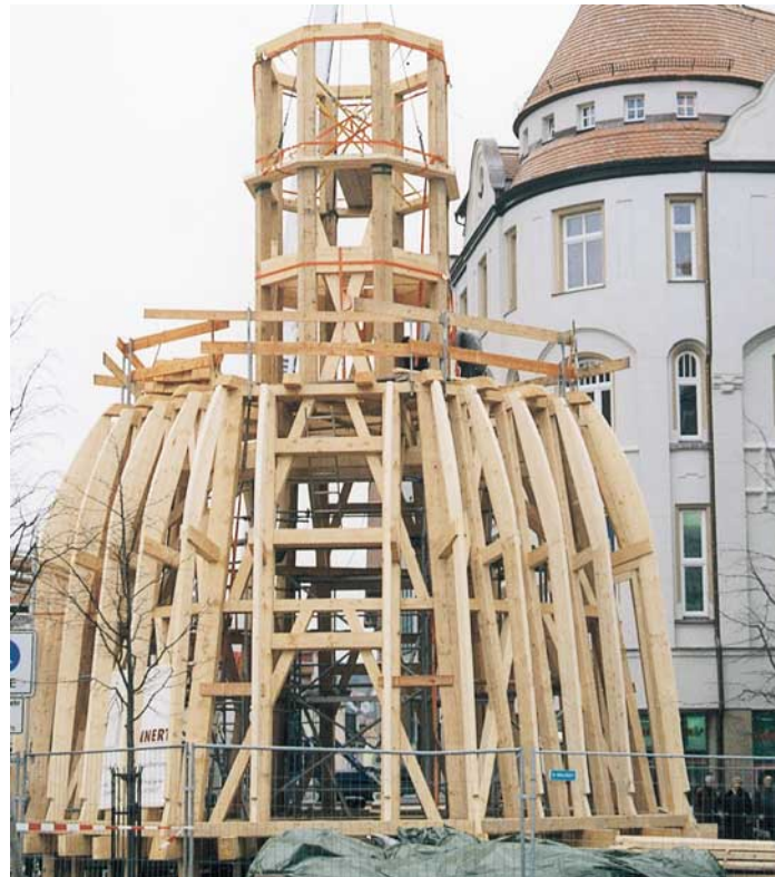
Abb. 7: Zimmerkonstruktion der Turmhaube einschließlich Laterne und Schablonen
