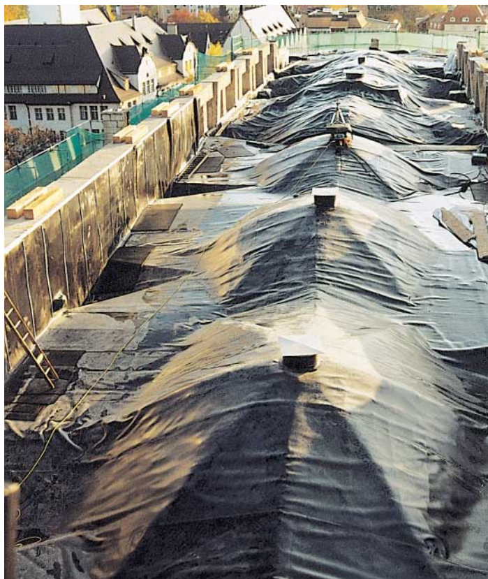
Abb. 5: Mit Abdichtung versehene Gewölbeoberseiten
