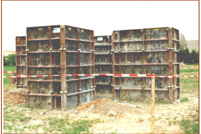
eingeschalte Fundamente
