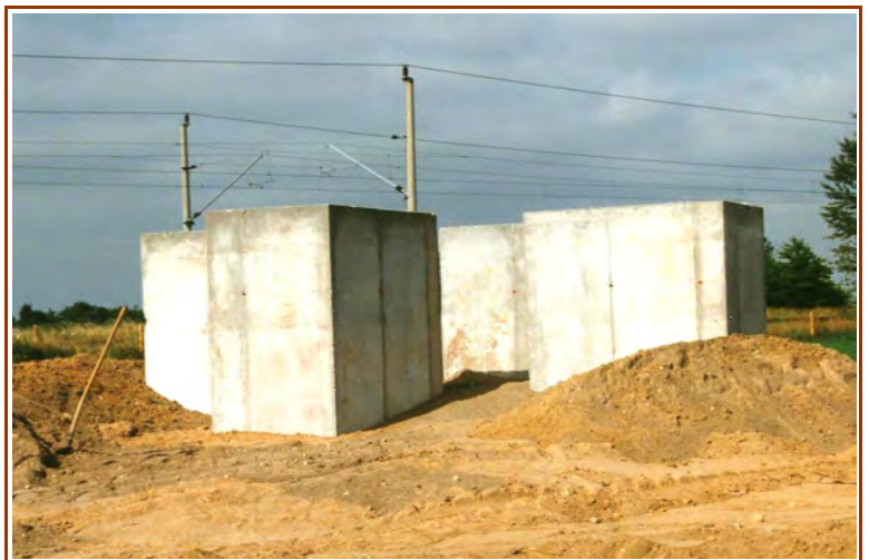
neue Stahlbetonfundamente für den Bockstuhl
