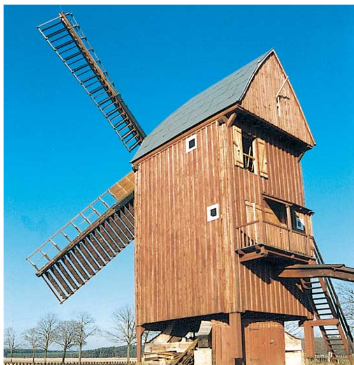
Abb. 9: Nach abgeschlossener Sanierung: Windmühle in Cammer
