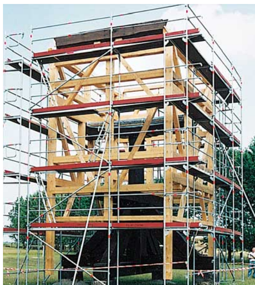
Abb. 8: ... hier mit eingesetzter Rutenwelle und Kammrad
