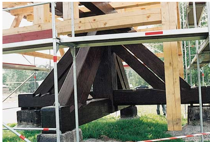
Abb. 6: Neu errichteter Bockstuhl in Reibitz
