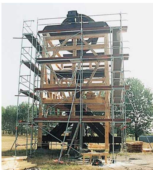
Abb. 7: Wiederaufbau des Mühlenhauses Reibitz ...
