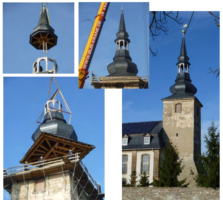
Aufsetzen der neuen Turmhaube am 01.02.2011
