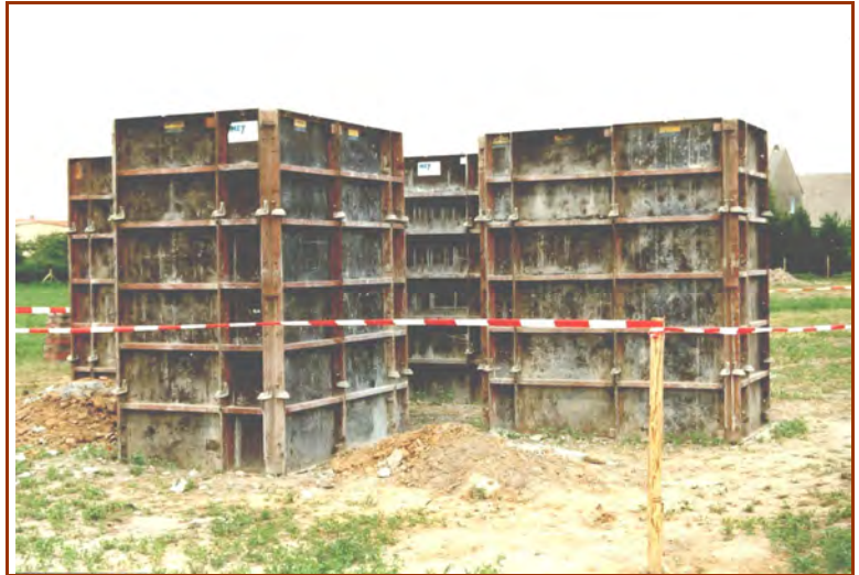
ingeschalte Fundamente
