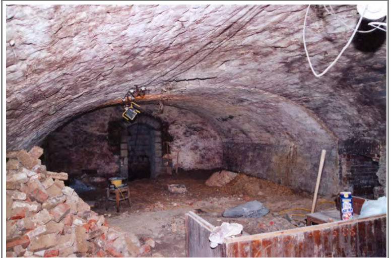
Gewölbekeller vor Umbau
