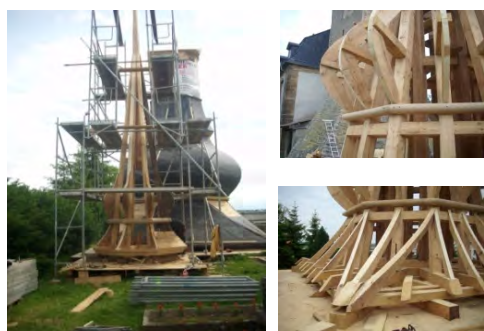
Neuaufbau der Turmhaube
