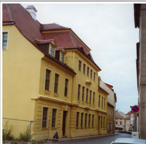
Straßenansicht nach Sanierung
