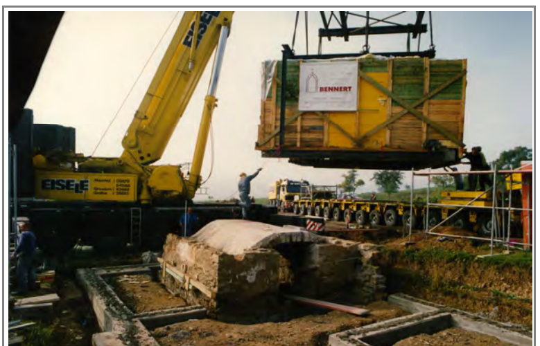
Aufsetzen des Erdgeschosses am neuen Standort
