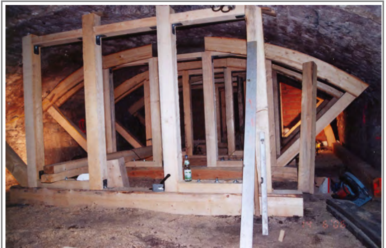
Abstützkonstruktion während der Bauphase
