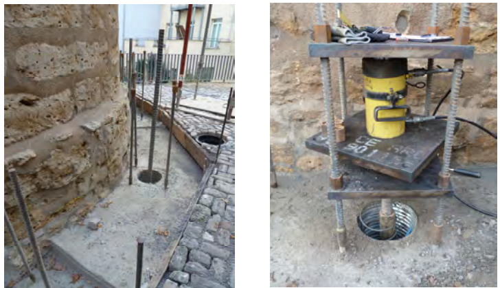
Bauarbeiten zur Gründungssanierung
