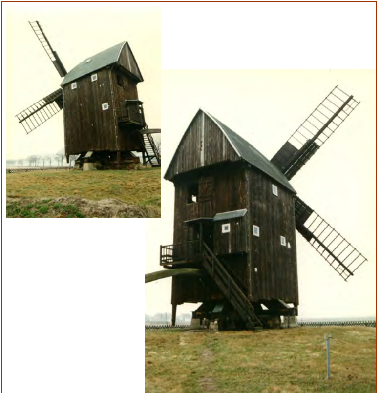
Mühle vor der Sanierung
