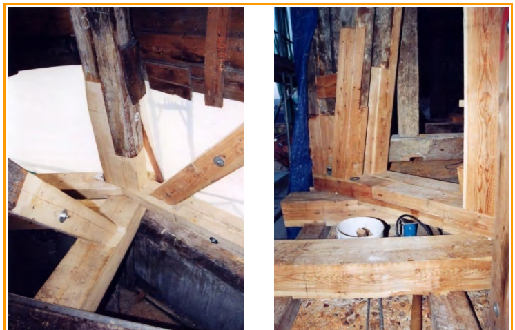
Sanierter Balkenkranz Turmhaube / Turmschaft
