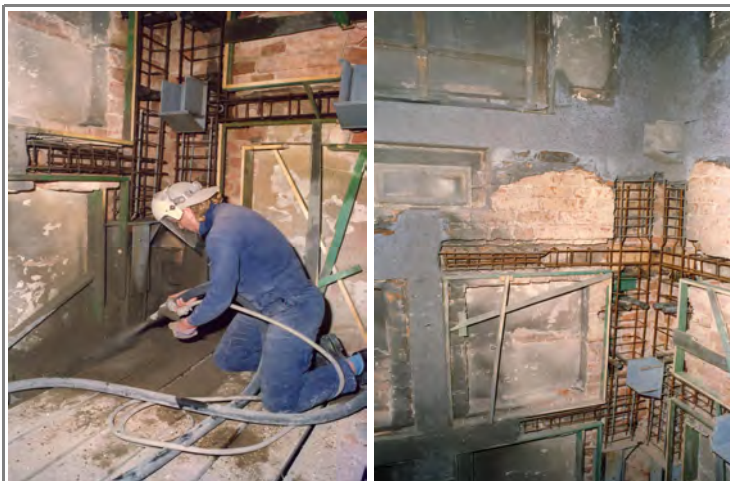
Sanierung der Tragkonstruktion mit Spritzbeton
