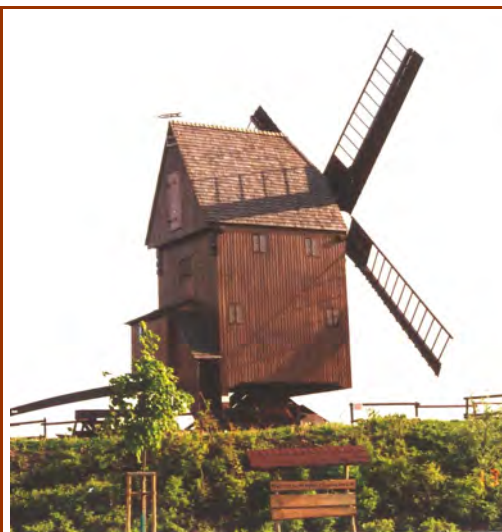
Windmühle nach der Rekonstruktion
