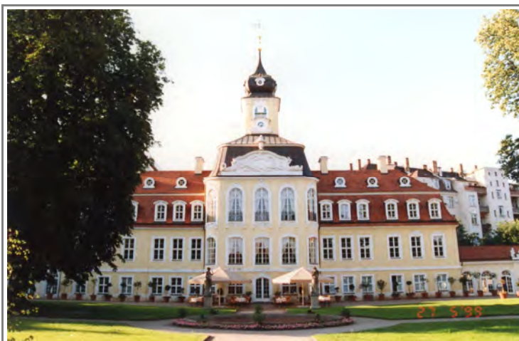
Gartenansicht nach Sanierung
