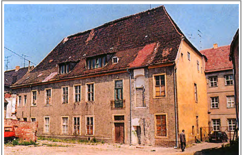
Hofansicht des Barockpalais vor der Sanierung
