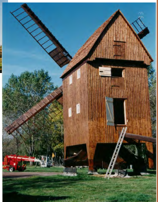
Mühle nach Wiederaufbau und Sanierung
