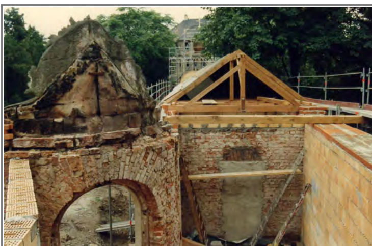
Sanierung der Wände/Dachkonstruktion Seitenflügel
