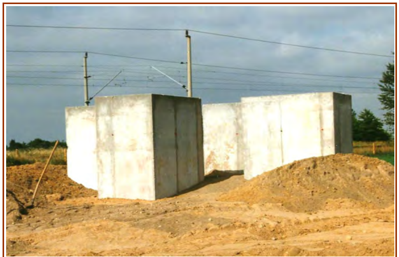
neue Stahlbetonfundamente für den Bockstuhl
