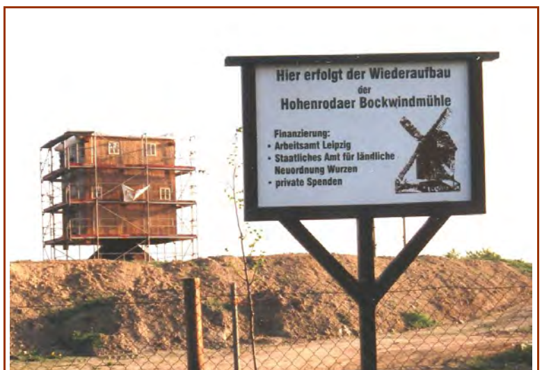
Wiederaufbau des Mühlenhauses
