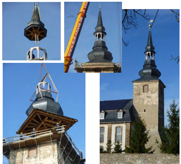
Aufsetzen der neuen Turmhaube am 01.02.2011
