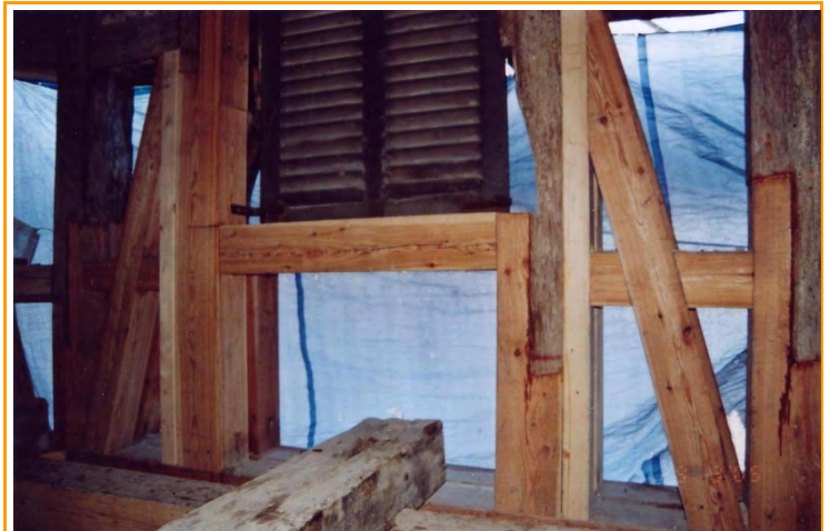
Sanierung Fachwerkkonstruktion - Turmschaft
