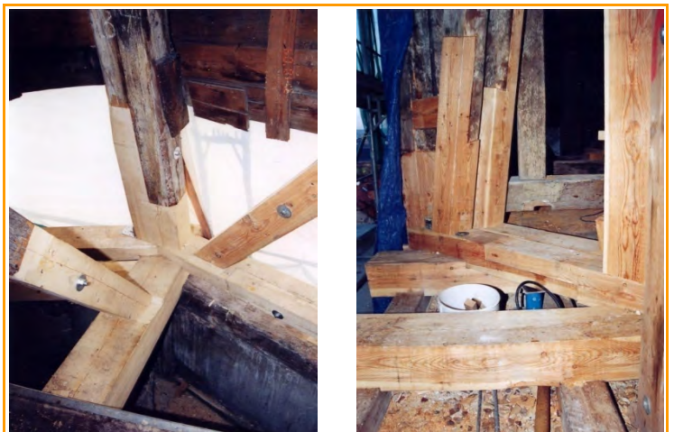
Sanierter Balkenkranz Turmhaube / Turmschaft
