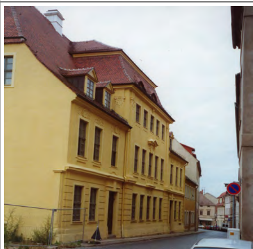
Straßenansicht nach Sanierung
