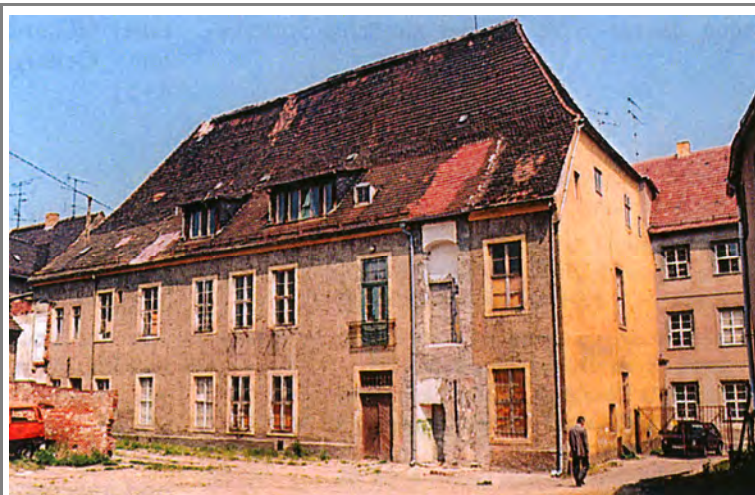
Hofansicht des Barockpalais vor der Sanierung
