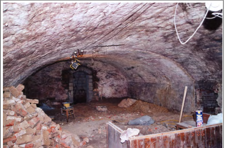
Gewölbekeller vor Umbau
