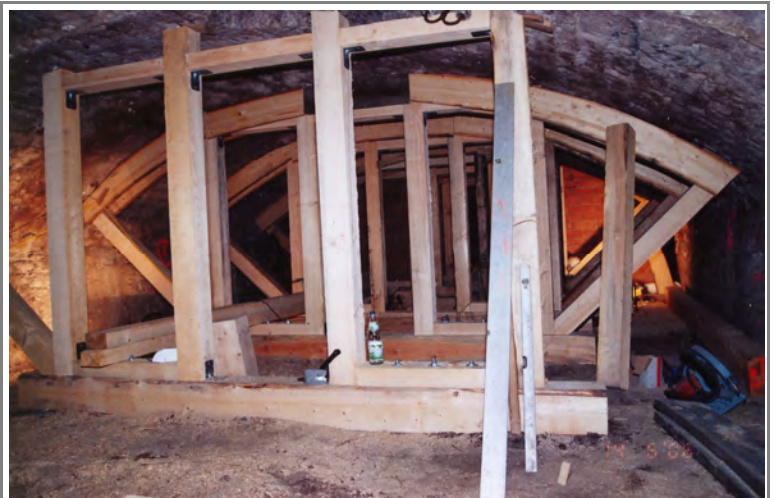
Abstützkonstruktion während der Bauphase
