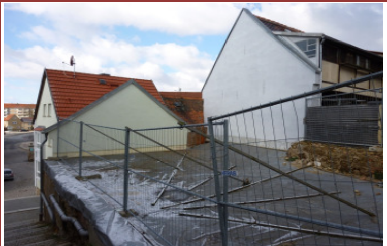
einsturzgefährdete Stützwände
