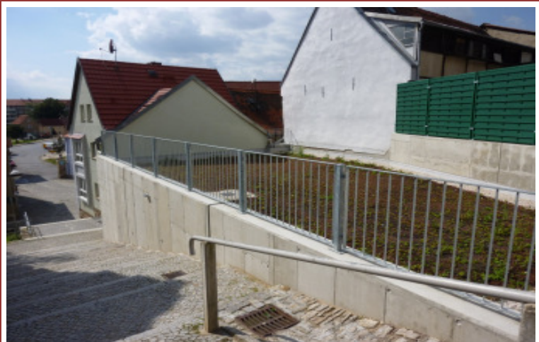
Stützwand 1 und 2 nach Fertigstellung
