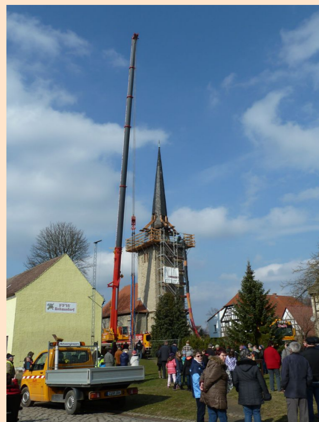
Stahl-/Holzkonstruktion für Turmhelmhub
