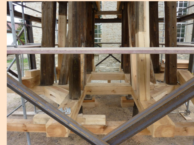
Detail neue Holzbauteile
