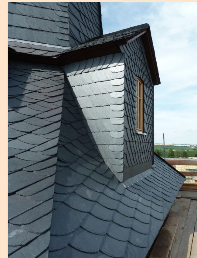
der neue Knopf ist montiert
