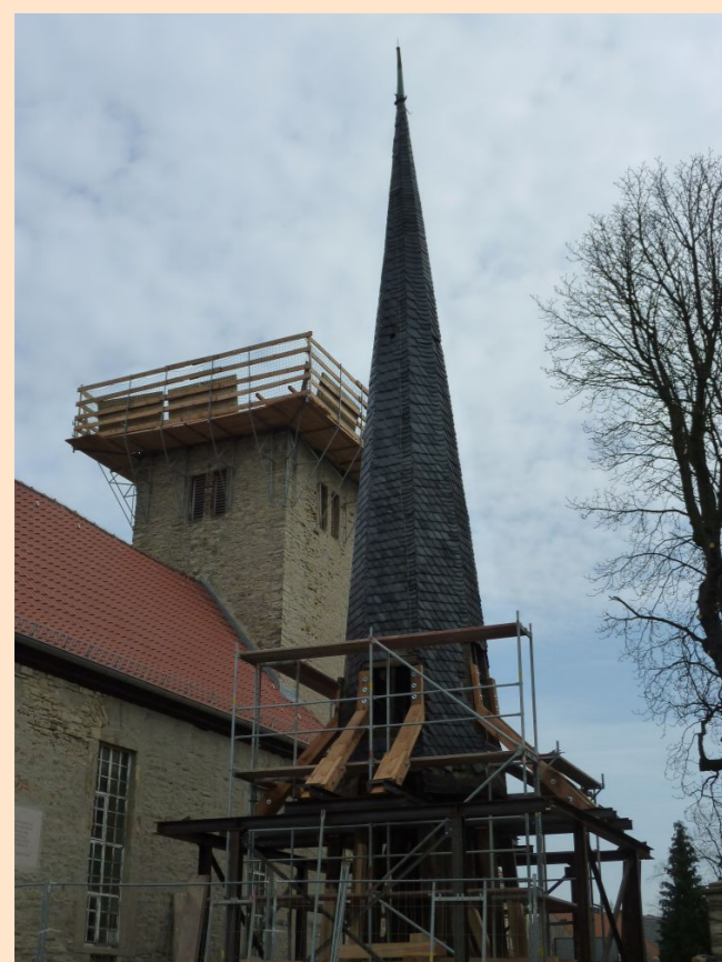
Turmhelm auf Montagegerüst abgestellt
