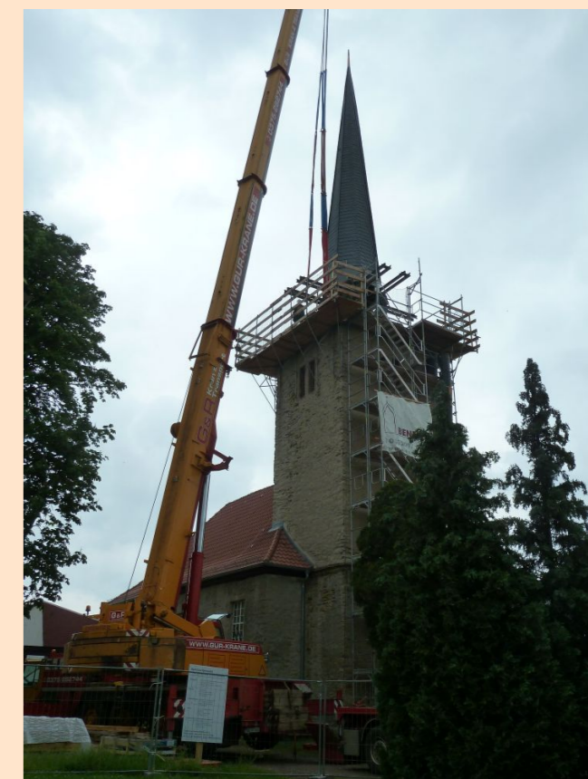
sanierter Turmhelm hängt am Kran
