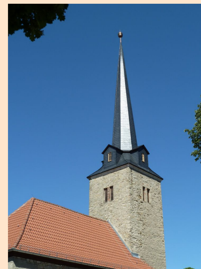
Ansicht der neuen Gaube
