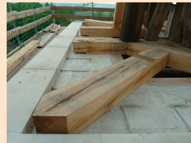
sanierter Turmhelm vor dem Aufsetzen
