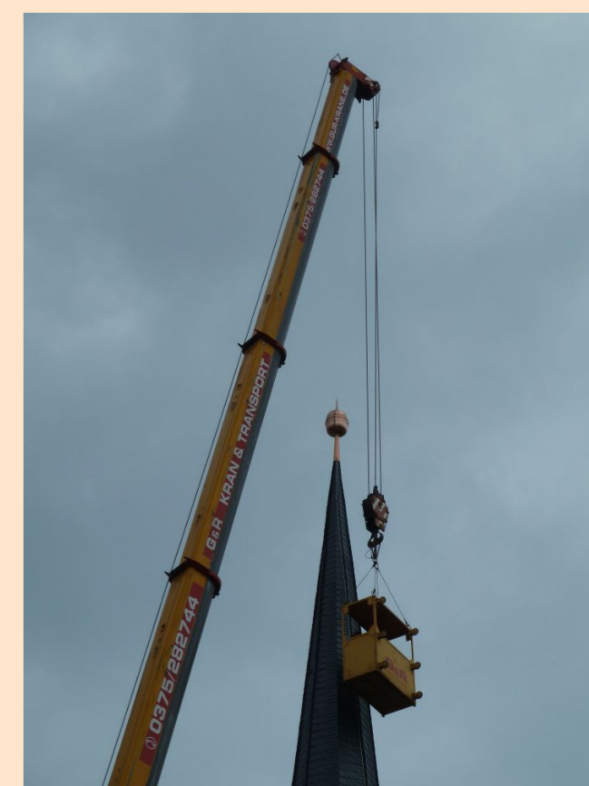
sanierter Turmhelm bereits aufgesetzt
