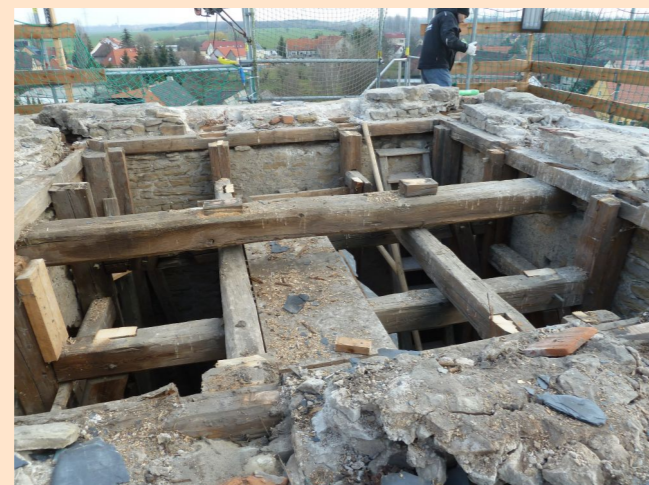
schadhafte Holzverbindungen
