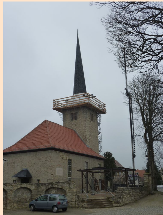
Einrüstung Turm und Herstellung Abstützbühne
